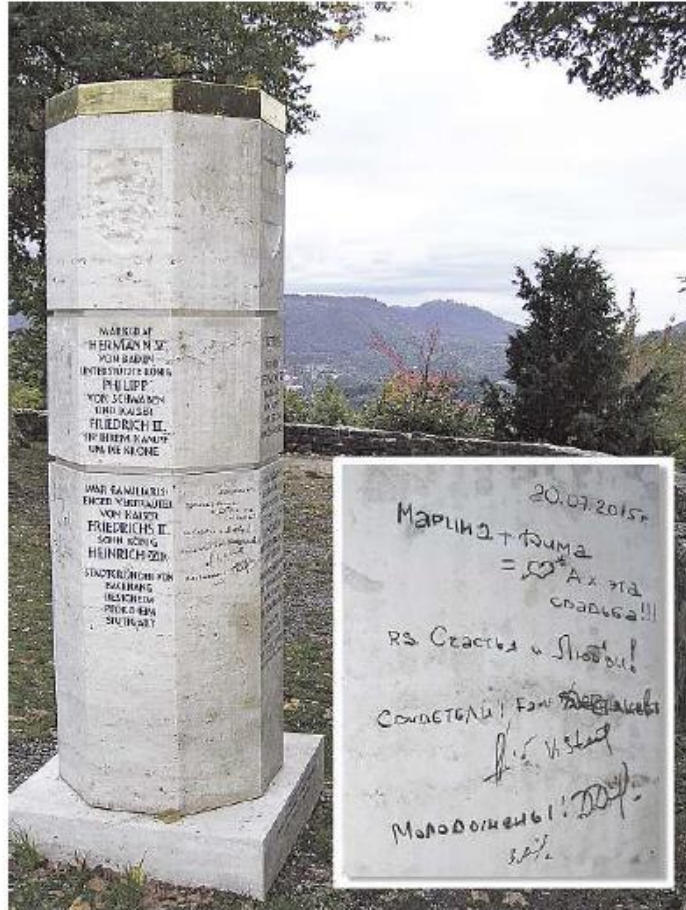
Immer wieder wird die Stauferstele beschädigt – zuletzt durch Filzstift-Schmierereien.
